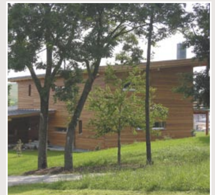
Holzhaus mit Lärchenfassade
