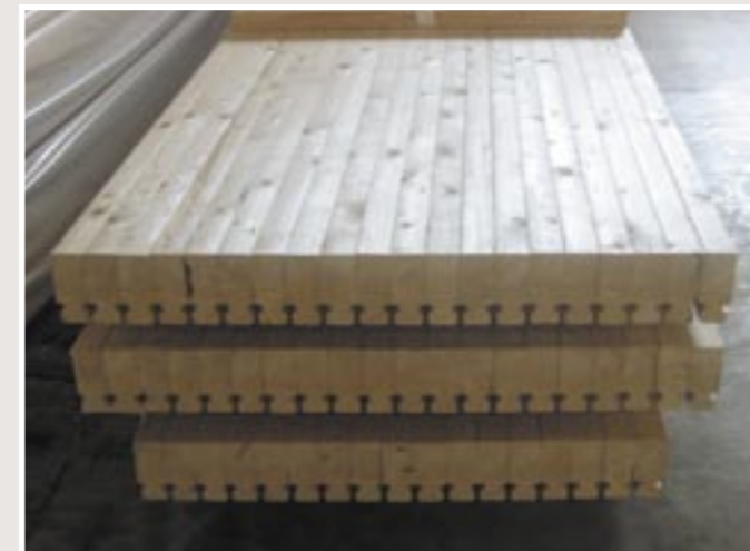
Brettstapeldecke mit Akustikhobelung
