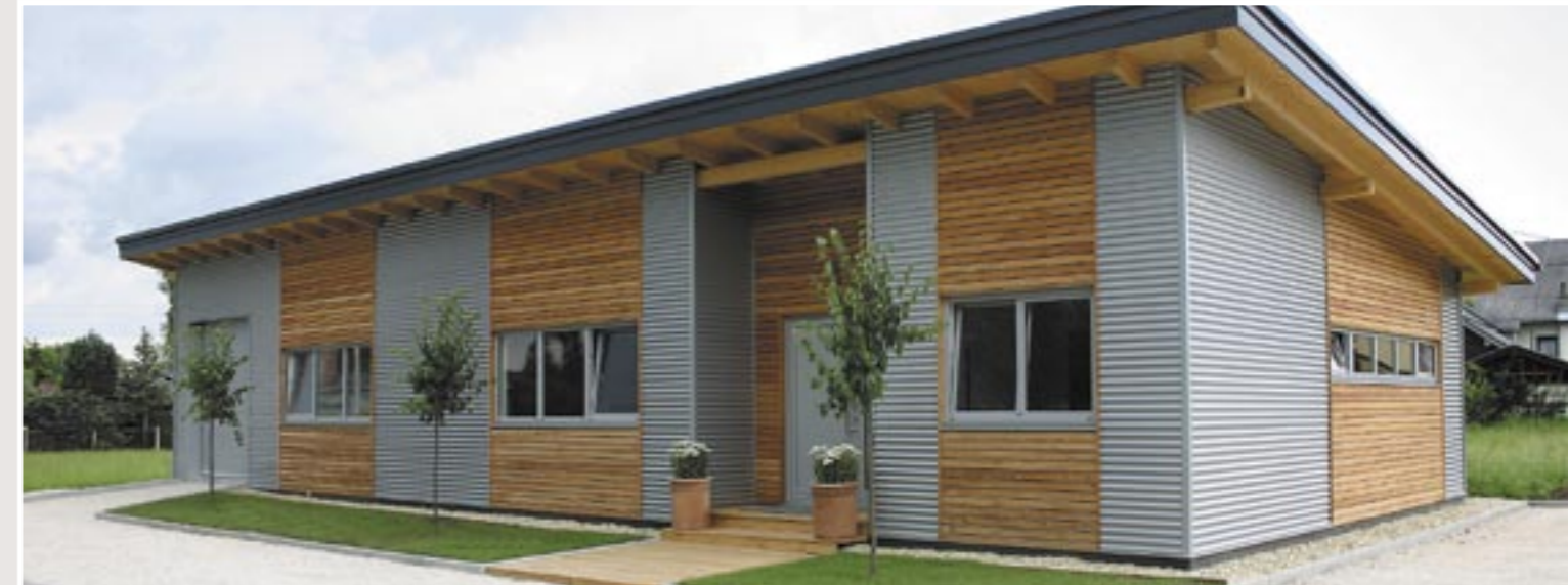
Firmengebäude in Holzriegelbauweise mit Lärchenschalung
