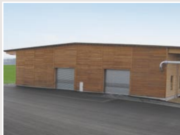
Holzhalle für Gewerbebauten in Kombination mit sägerauer Fassade.
