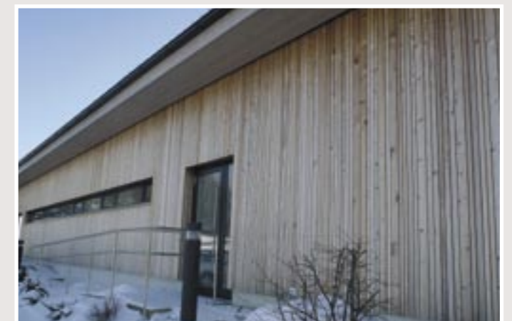
Lärchenfassade mit verschiedenen Breiten
