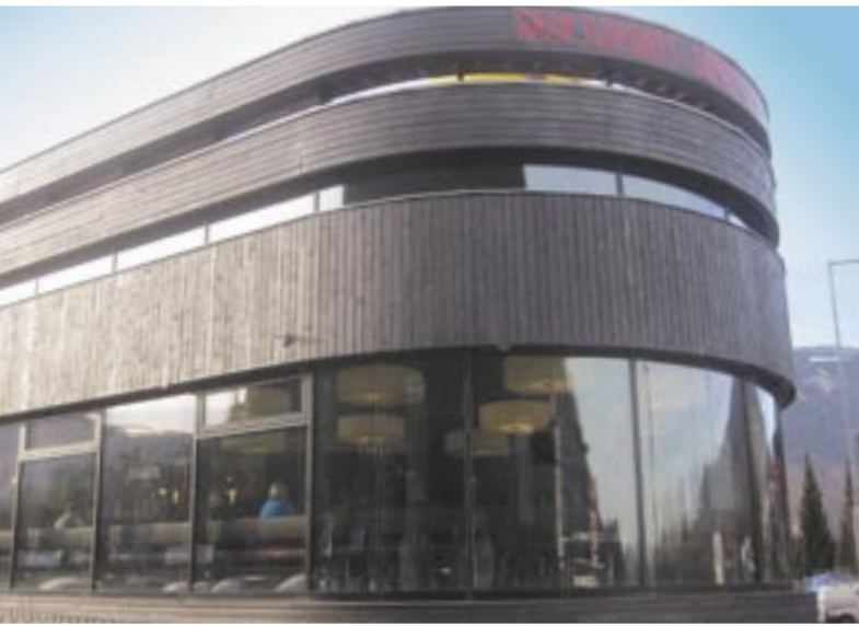
Sägerauhe Fassade mit Vergrauungslasur
